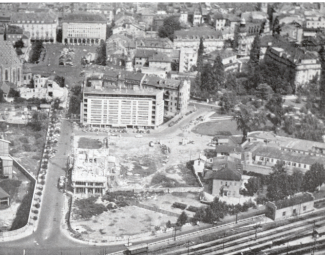
Il Cantiere dell'Autostazione negli anni '50 Die Baustelle des Busbahnhofes in den 1950er Jahren
