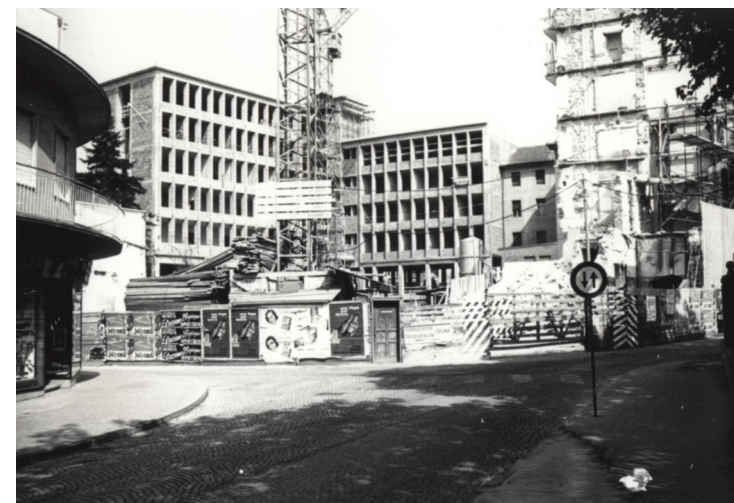
Il Cantiere del Nuovo Municipio negli anni '50 Die Baustelle des Neuen Rathauses in den 1950er Jahren
