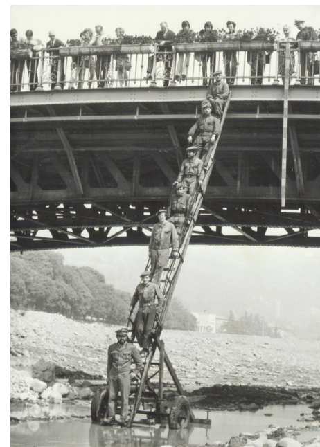
Lavori di realizzazione dei Prati del Talvera, 1971-1972 / Bauarbeiten für die Talferwiesen, 1971-1972
