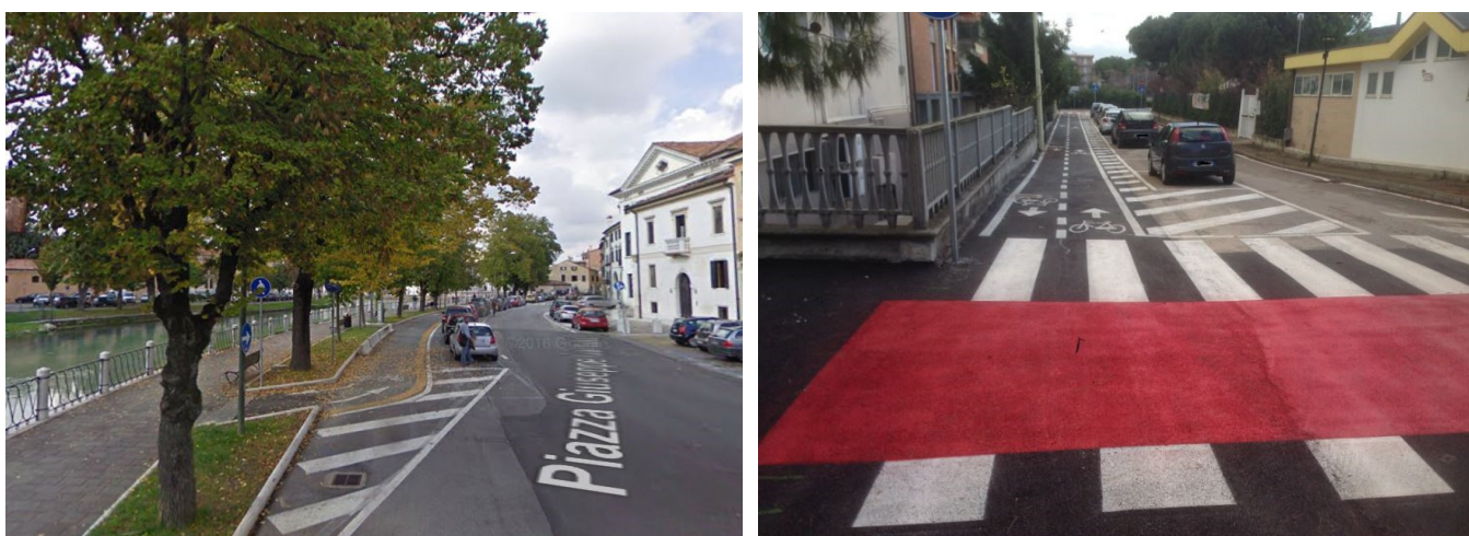
Figg. 29.4 Esempi di pista ciclabile in sede propria bidirezionale separata da fascia di sosta
