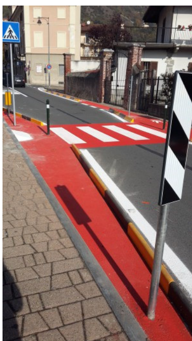
Figg. 26.11 Esempi di strettoia in corrispondenza di attraversamenti pedonali
