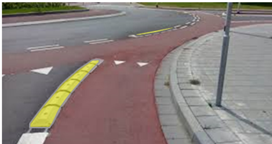
Fig. 20.2 - Protezioni dei percorsi ciclabili “babane vèlo”
