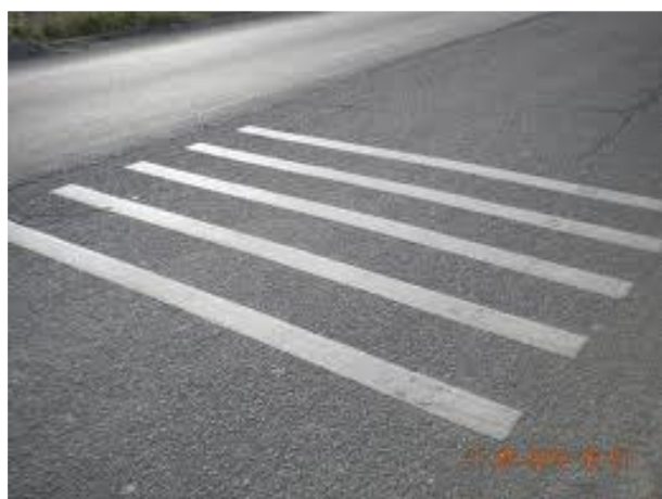
Fig. 26.2 Esempio di bande sonore e pettini sonori
