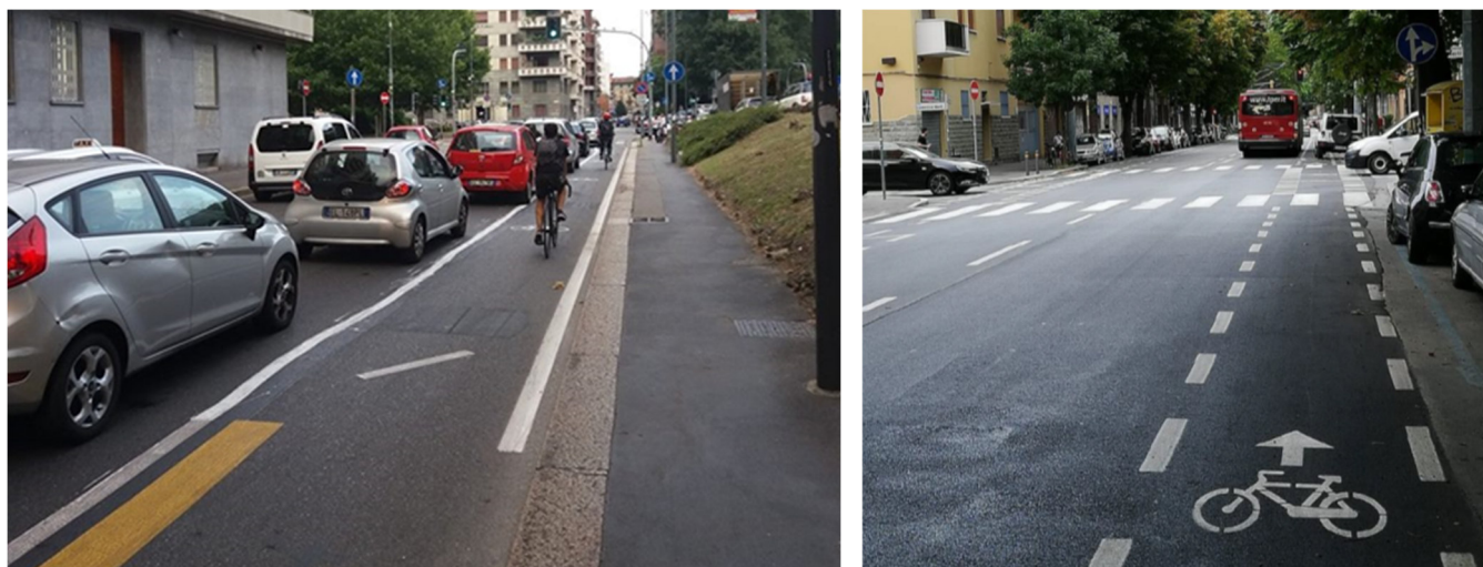
Figg. 29.11 Esempio di corsia ciclabile con linea continua e di corsia ciclabile con linea discontinua in corrispondenza di una fascia laterale di sosta
