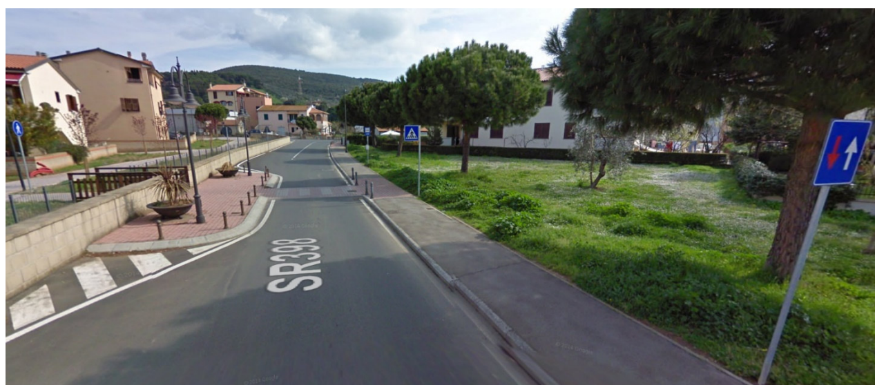
Fig. 26.14 Esempio di attraversamento pedonale protetto da una strettoia con istituzione del senso unico alternato (Venturina - LI)
