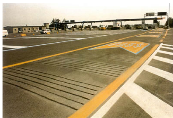
Fig. 26.2 Esempio di bande sonore e pettini sonori
