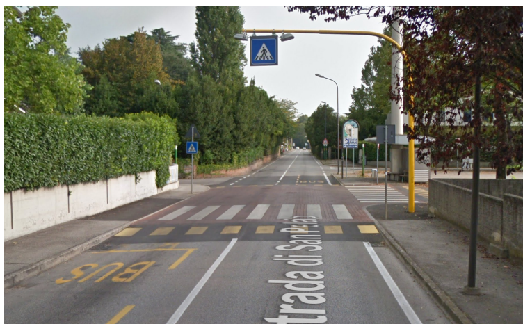
Fig. 26.4 Esempio di incrocio rialzato
