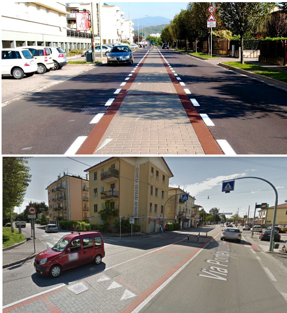
Figg. 26.17 Esempi di corsie polifunzionali (Padova)
