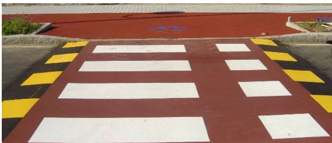
Fig. 30.3 Esempio di attraversamento ciclopedonale con leggera sopraelevazione
