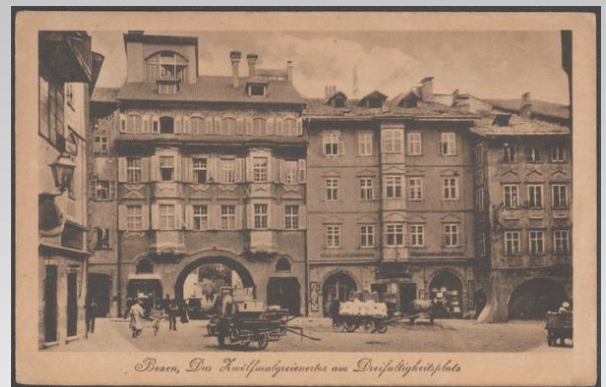
Cartolina storica con l'edificio in Piazza della Trinità.
