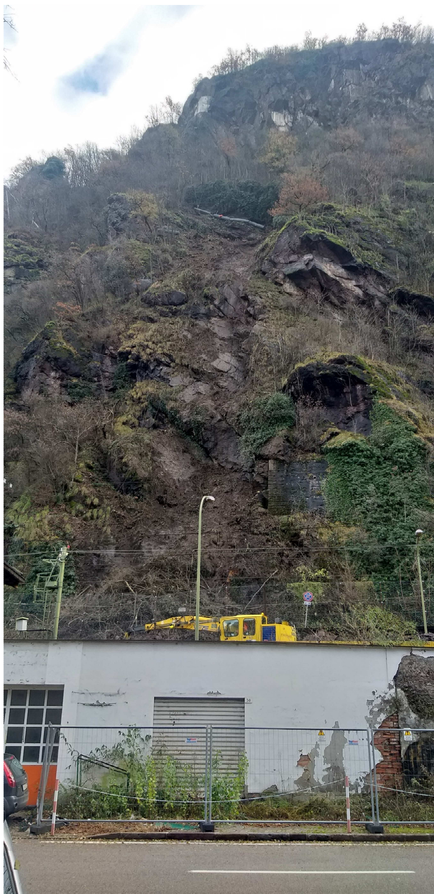
Foto 4: ore 12.30 del 10 dicembre. Presenza dei rotoli di rete in testa alla frana. Presenza al piede del canalone del materiale disgaggiato e del legname tagliato. Iniziati i lavori di rimozione del materiale sui binari da parte di RFI
