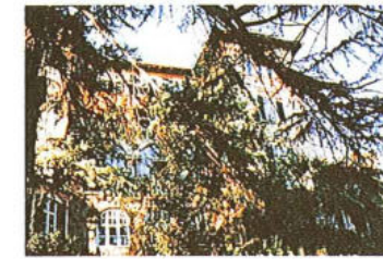
83 Villa - via della Torre 6 p.ed. 131/1 + p.f. 187/3/16/17
