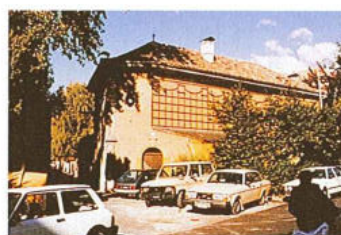
16 Casa - via C. Roncolo 7 - p.ed. 11 + p.f. 7/3
