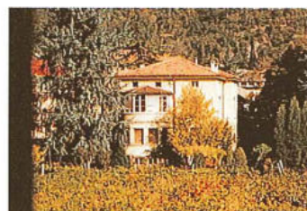
10 Villino - via Weggenst. 11 - p.ed. 1122
