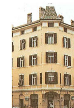
105 Palazzina - via Latemar 11 p.ed. 667
