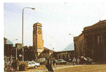
98 Torre Stazione - Via Renon 4 - p.ed. 514
