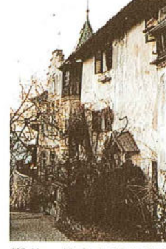
138 Maso - Via Costa di Sotto 8/9/9a/ 9b - p.ed. 266
