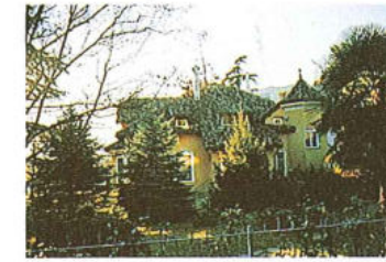
86 Villa - via della Torre 16 - p.ed. 632 + p.f. 187/5
