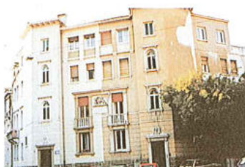
25 Palazzina - v.le Venezia 44 - v. Fiume 6 p.ed. 860 - 861 - p.f. 2152/44
