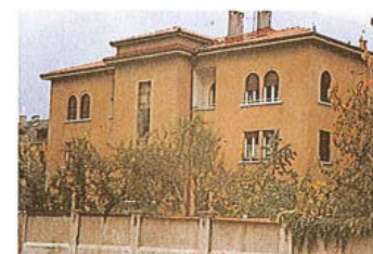
11 Villino - via Weggenst. 13 - p.ed. 1123
