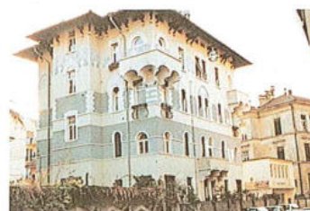
27 Palazzina - via Fiume 7 - p.ed. 823
