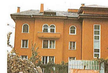
12 Villino - Weggenstein - p.ed. 1123
