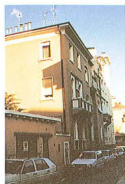
168 Palazzina via Fiume 8 p.ed. 862
