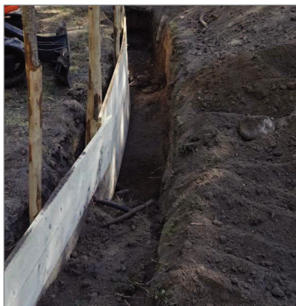
Figura 3: Realizzazione della trincea e dell'assito di protezione
