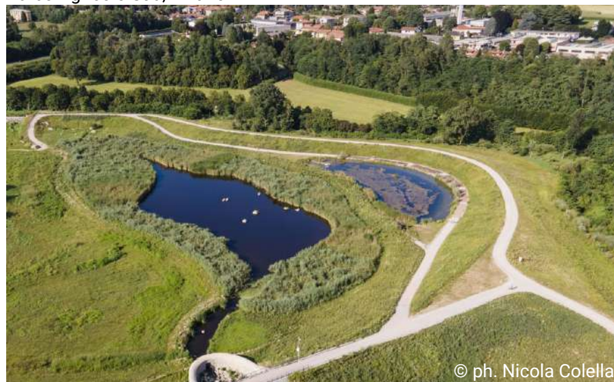
Vasca di laminazione del torrente Lura, Lomazzo, Como - LAND
