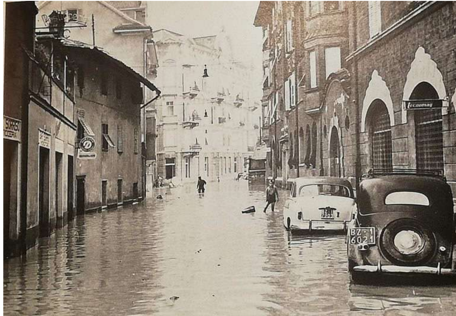
Via Brennero allagata dopo l'alluvione | 1957
