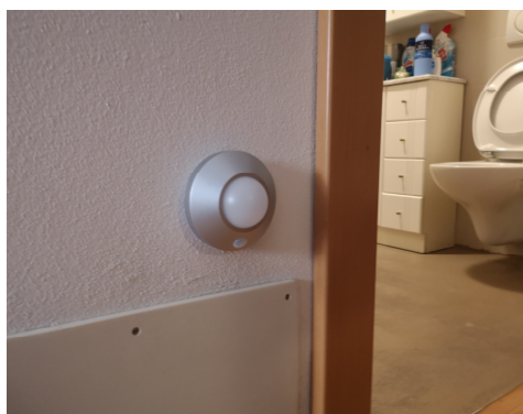
Immagine 4.1.9 Il sistema di illuminazione notturno automatico.
